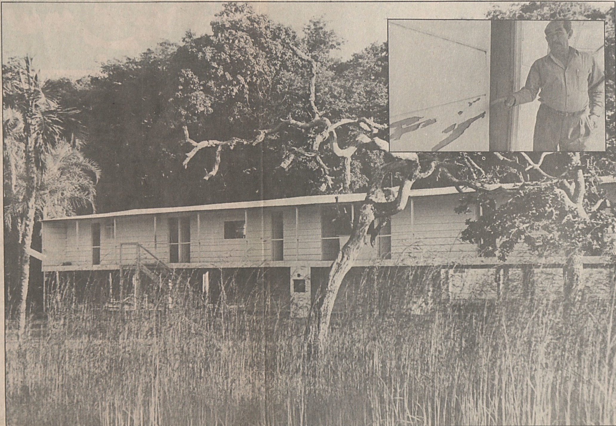
Os especialistas vão cuidar da orientação dos trabalhos de recuperação completa, onde estão incluídas as mudanças de peças de madeira corroídas por cupins
