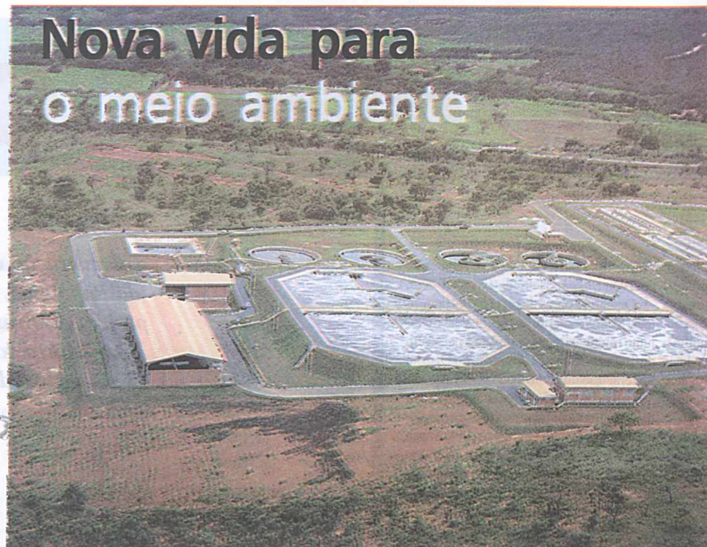
ETE Gama evita que quase 480.000 metros cúbicos de esgotos sejam lançados em estado bruto nos rios Alagado e Ponte Alta
