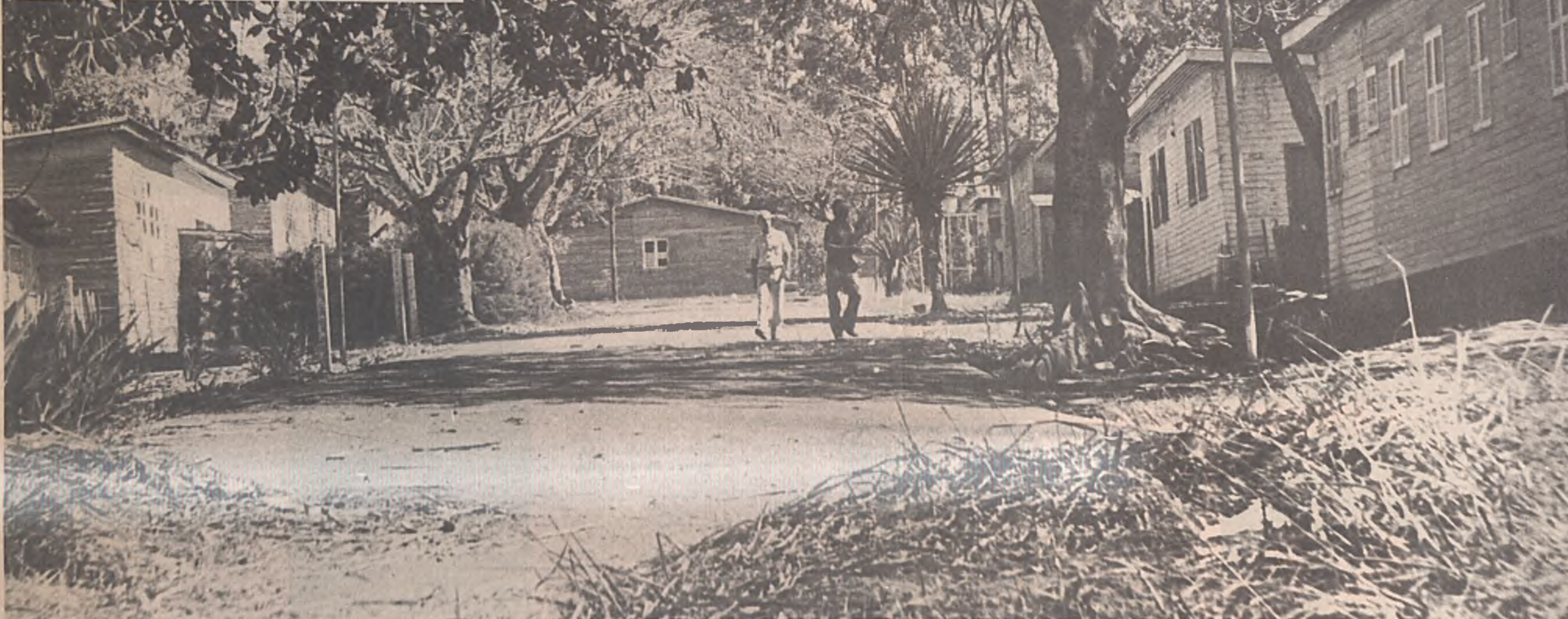
O estado geral de conservação é precário devido a má conservação
