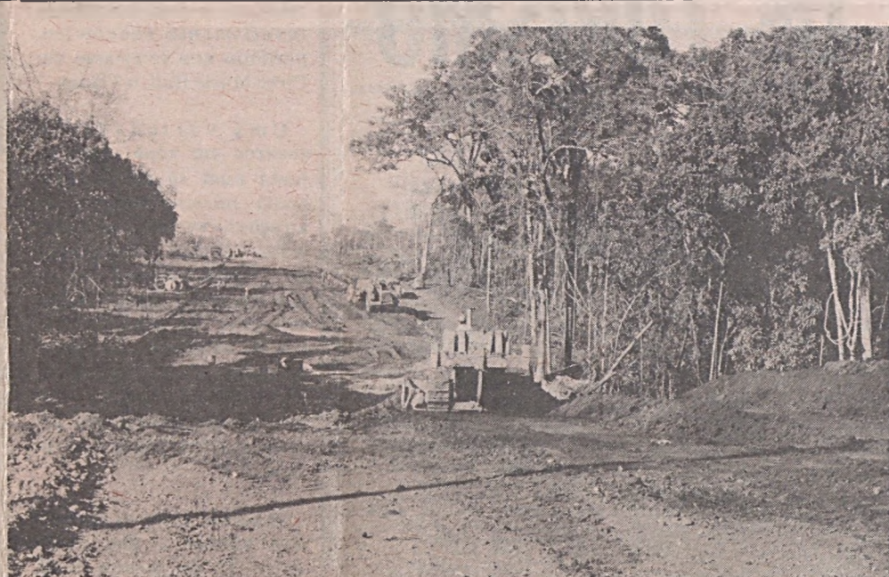
A Implantada, grande parte em obras
