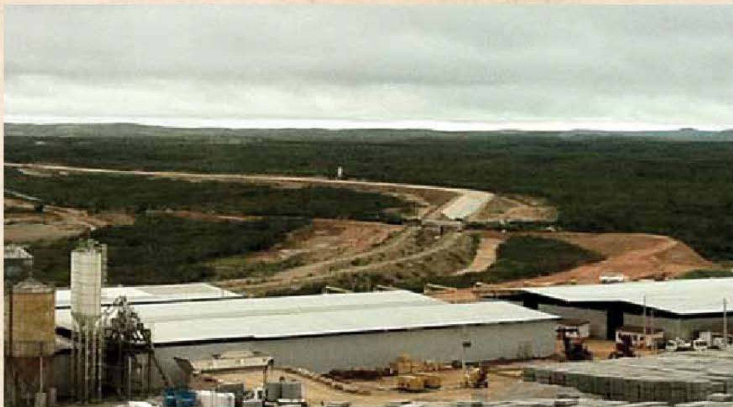
Canteiro de obras da transposição do rio São Francisco
