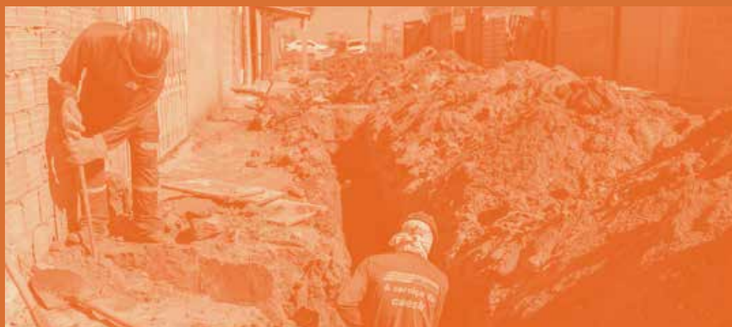
Caesb informou que iniciou obras para levar rede de água à comunidade Fazendinha | Crédito: Cristiano Carvalho/Caesb
