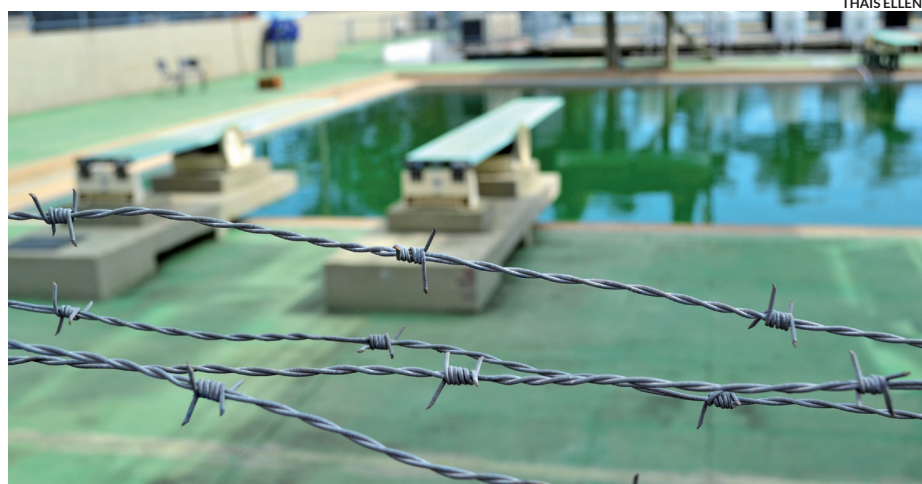
A reabertura das piscinas do CO depende agora da troca de três bombas e um filtro que fazem circular a água e a mantêm limpa
