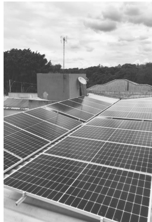
Instalação das placas fotovoltaicas em região nobre do DF | Brasília Solar Energia Fotovoltaica/Divulgação
