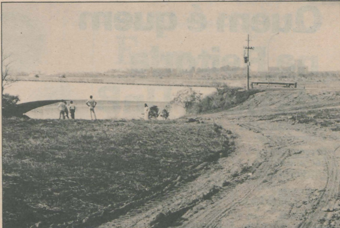
Com o começo das obras a ciclovia do Lago deverá ter seus trabalhos concluídos em novembro
