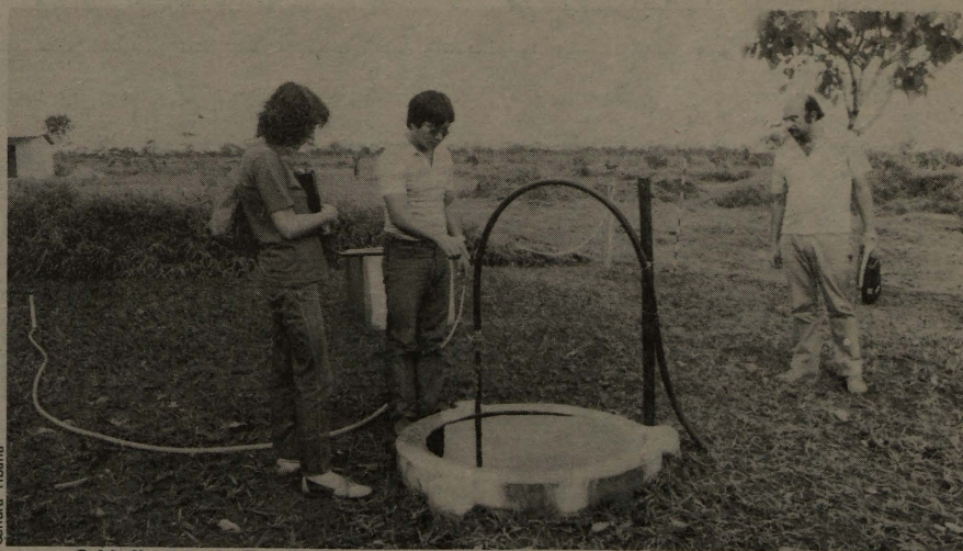
O biodigestor da Fazenda Água Limpa já está produzindo gás e fertilizante orgânico
