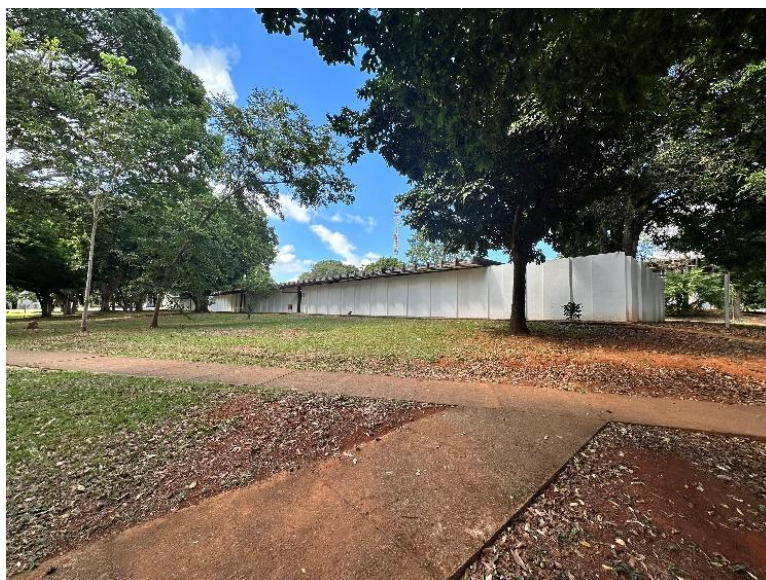
Figura 2: Fachada do edifício SG-10
