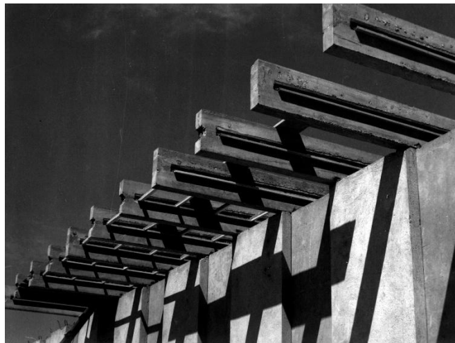
Figura 9: Vigas apoiadas no encontro entre duas placas pré-fabricadas em concreto
