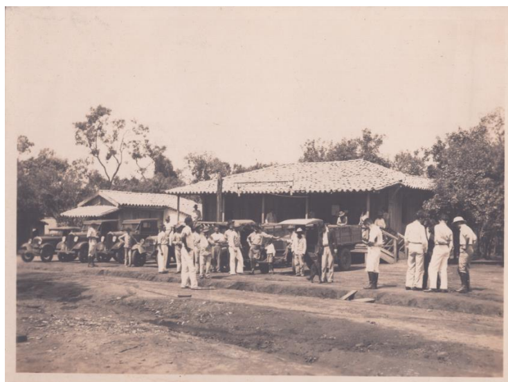
Figura 8: Edificações na “Currutela”, o assentamento provisório às margens do Córrego Botafogo.
